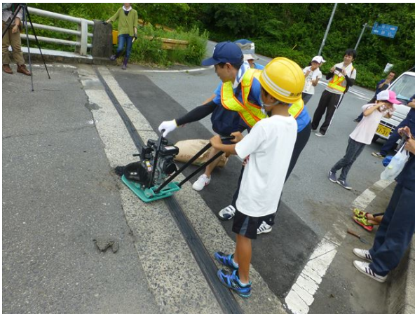
写真-1 橋守活動 2017/07/02 (タンパによる補修体験)
