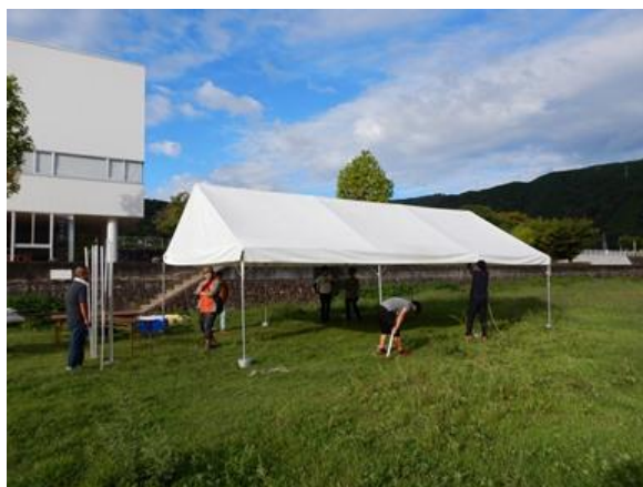
【屋外テント設置】
