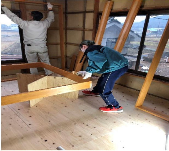
美大生と建築構造技術者による作業風景
