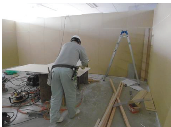
内装工事（木工事）
