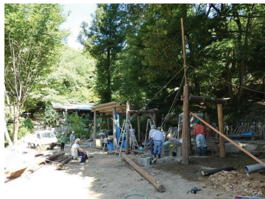
土砂災害で流失した炊事棟の再建で棒に滑車をつけて、柱を引っ張り上げているところ
