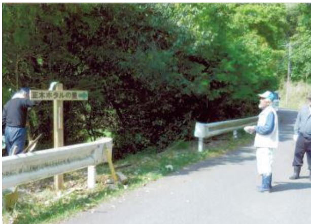
矢印表示板の設置。
