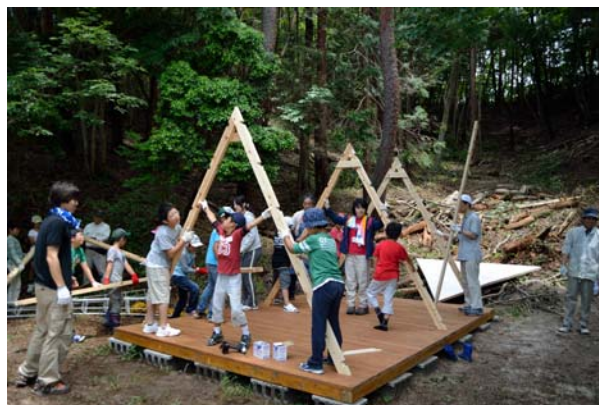
ログテントの骨組みづくり
