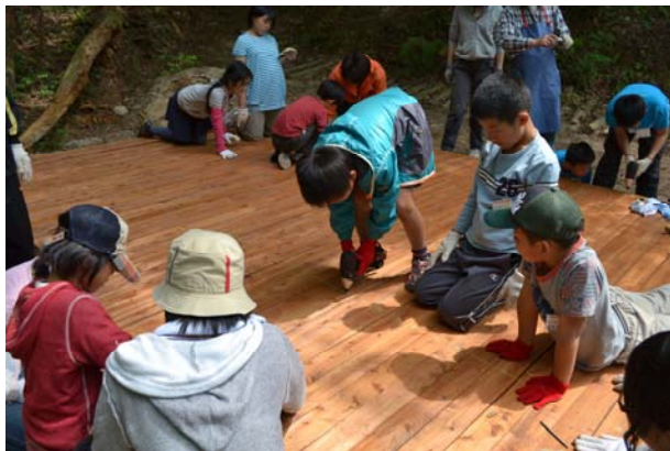
デッキづくり
