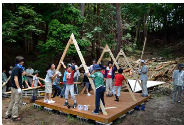
ログテントの骨組みづくり
